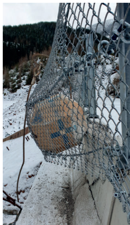
Obr. 3: Zásah záchytnej konštrukcie mobilnej bariéry TS-100 MOBIL
