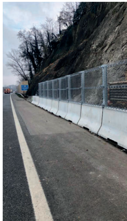
Obr. 5: Aplikácia mobilnej bariéry na ochranu diaľnice
