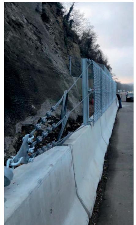
Obr. 6: Aplikácia mobilnej bariéry na ochranu diaľnice
