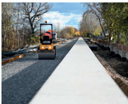
Príprava koľajového zvršku
