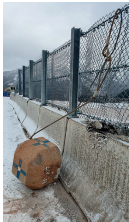
Obr. 2: Zásah betónového prvku mobilnej bariéry TS-100 MOBIL
