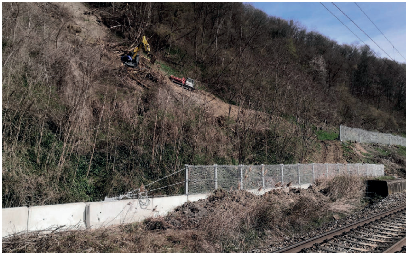
Obr. 7: Aplikácia mobilnej bariéry na ochranu železničnej trate
